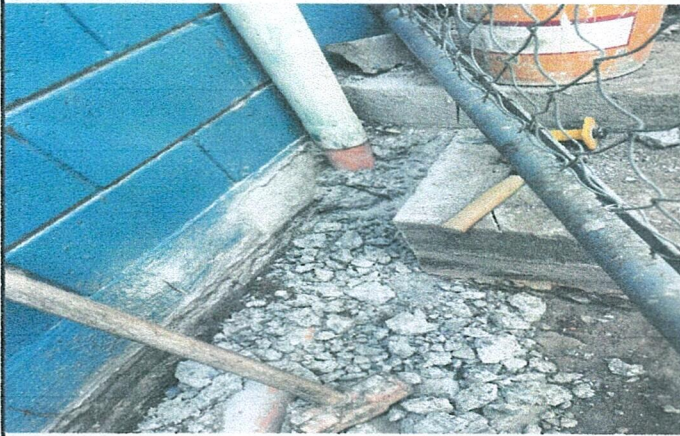
Foto 3: Instalacion de base para colocación de tinaco.
