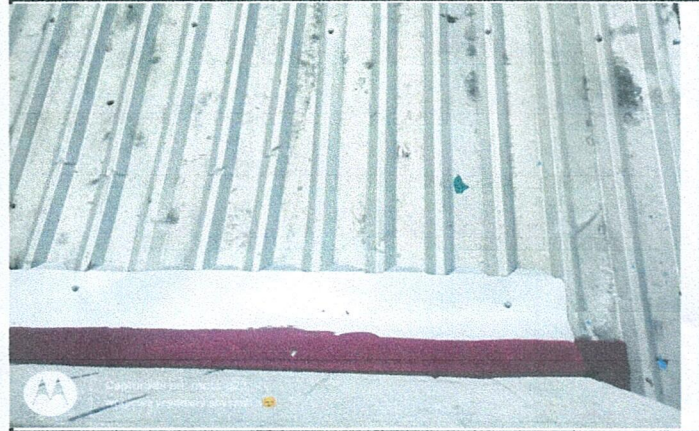
Foto 2: Mejoramiento de estructura tipo portico e instalacion de lamina troquelada calibre 16
